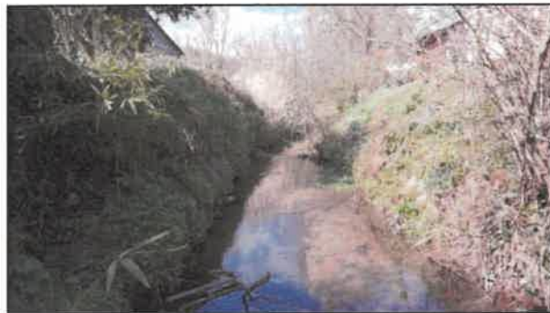
Lit du Merdaret avant travaux
