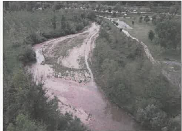
Vue du site après travaux (prise de vue aérienne)
