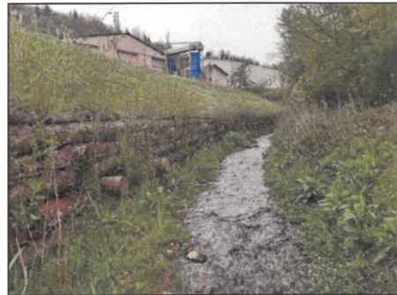
Lit du Merdaret après travaux
