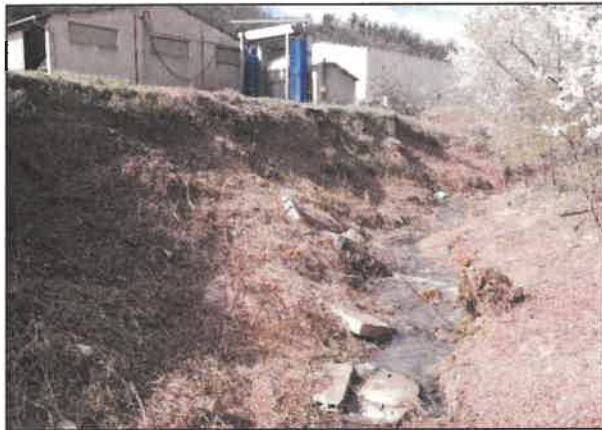
Lit du Merdaret avant travaux
