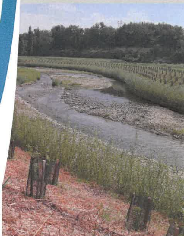
Restauration des berges de l'Herbasse en amont des aménagements de protection contre les crues à Clérieux
