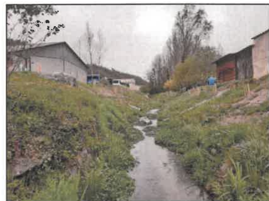
Lit du Merdaret après travaux
