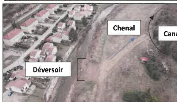
Vue aérienne du chenal créé entre le déversoir et le canal
