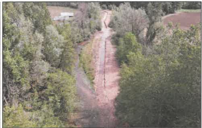
Vue du site après travaux
