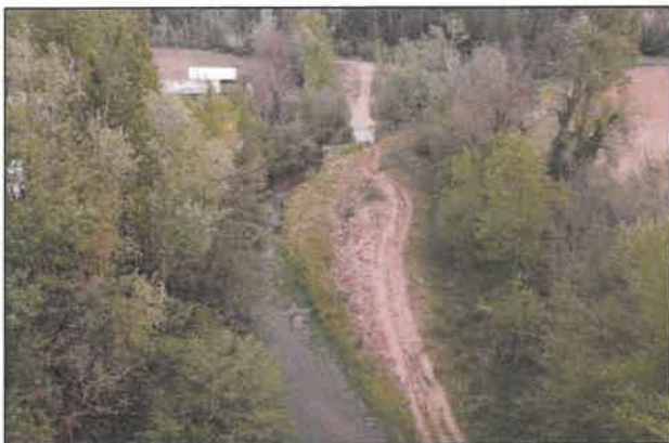
Vue du site avant travaux
