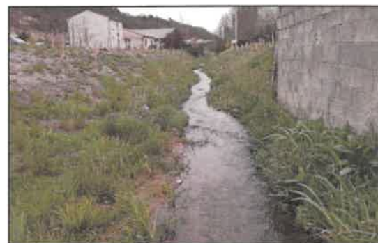
Lit du Merdaret après travaux
