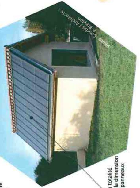
Les panneaux couvrent la totalité de la toiture de l'annexe dont la dimension a été ajustée à la taille des panneaux
